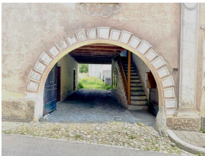
unten: Portal zur Via Sum il Vitg mit Durchgang zum Garten und Aufgang zu Laube und Schopf sowie zum 1. Stock
