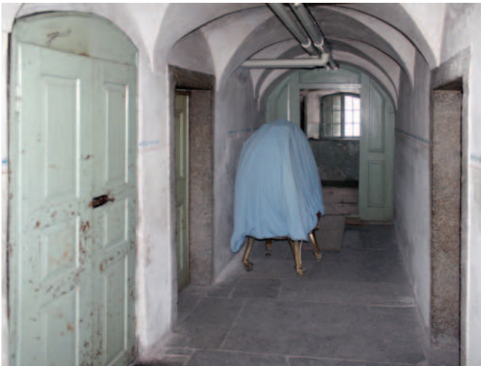
Erdgeschosskorridor mit feinem Kreuzratgewölbe und Steinplattenboden. Blick gegen Osten. Foto DPG 2016
