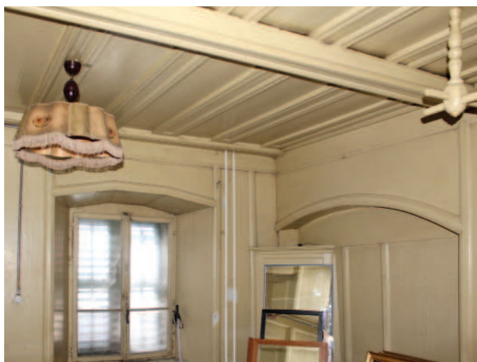
Erstes Obergeschoss, Raum im Nordwesten mit profilierter Decke und Unterzug und verm. originalem Fenster. Foto DPG 2016
