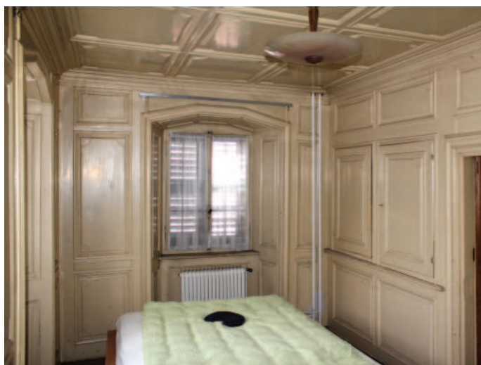
Erstes Obergeschoss, östliche Nebenstube. Foto DPG 2016
