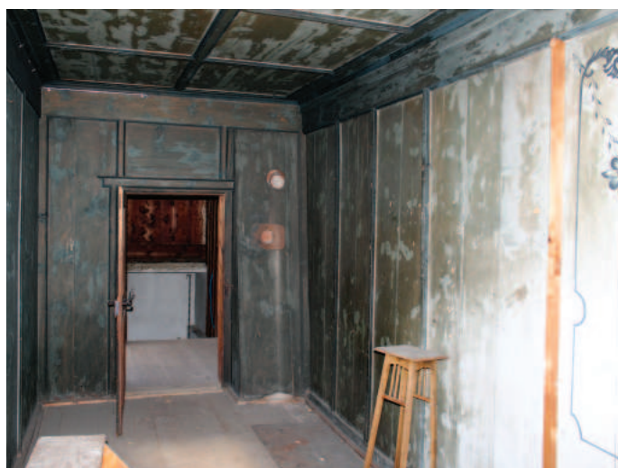
Mansardgeschoss, westliche Kammer an der Südseite des Hauses. Foto DPG 2016
