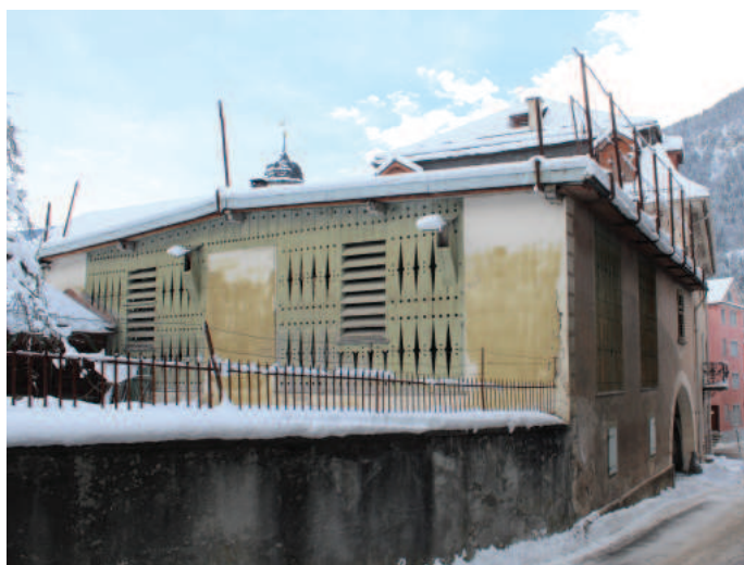
Pfeilerstallscheune mit flach geneigtem Satteldach und ornamental gesägten Ausfachungen. Ansicht von Nordwesten. Foto DPG 2016
