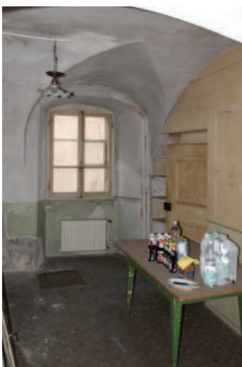
Erstes Obergeschoss, Spensa mit Brettertrennwand zur Küche und ornamentalem Linoleumbodenbelag. Foto DPG 2016
