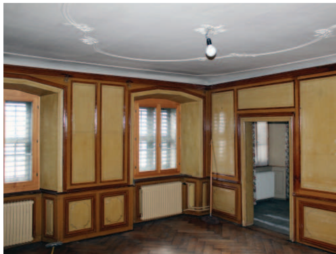
Zweites Obergeschoss, mittlerer südseitiger Raum mit Stuckdecke und verm. im oberen Bereich ergänztem Wandtäfer. Foto DPG 2016
