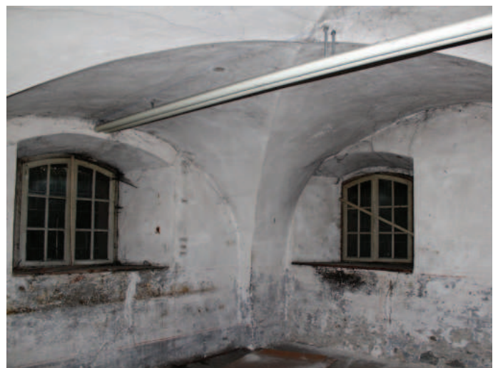
Erdgeschoss, südwestlicher Raum mit Kreuzratgewölbe und Riemenboden. Foto DPG 2016
