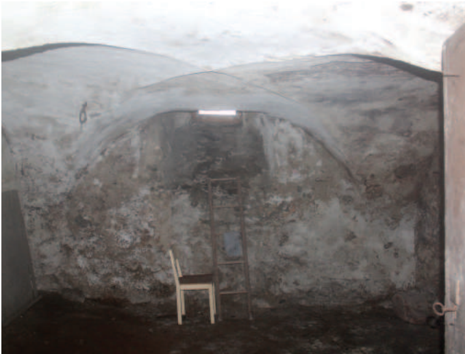
Kellerraum im Südwesten mit Kreuzratgewölbe und Naturboden. Foto DPG 2016
