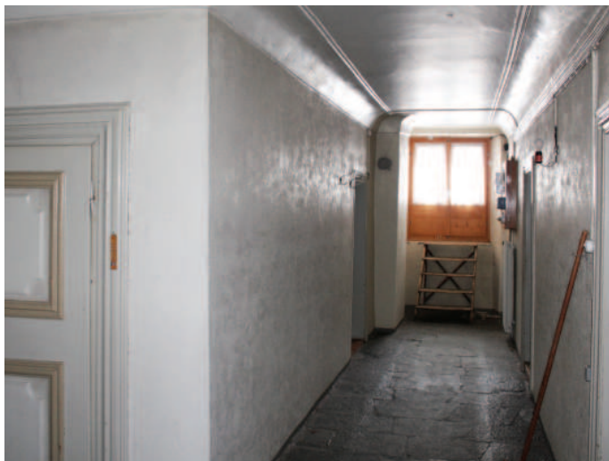
Zweites Obergeschoss, abgewinkelter Korridor mit gekehlter Stuckdecke. Blick gegen Norden. Foto DPG 2016
