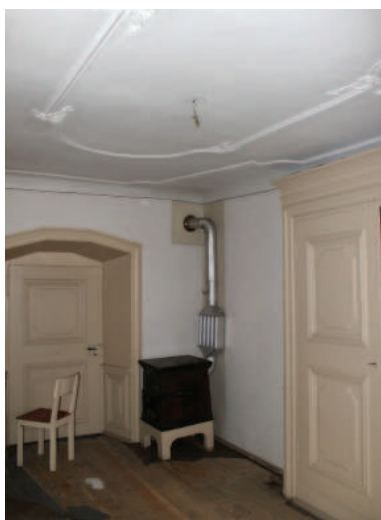
Zweites Obergeschoss, westlicher Raum an der Südseite des Hauses. Foto DPG 2016
