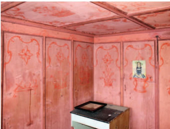
Mansardgeschoss, nordwestliche Kammer. Foto DPG 2016
