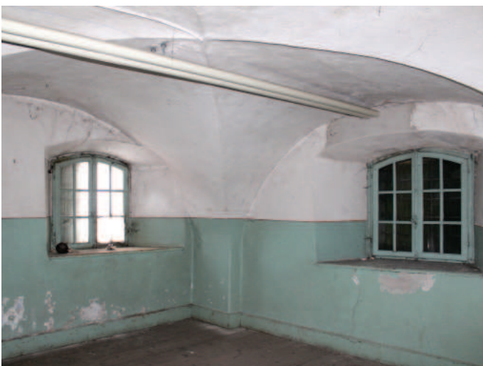
Erdgeschoss, südöstlicher Raum mit Kreuzratgewölbe und Riemenboden. Foto DPG 2016
