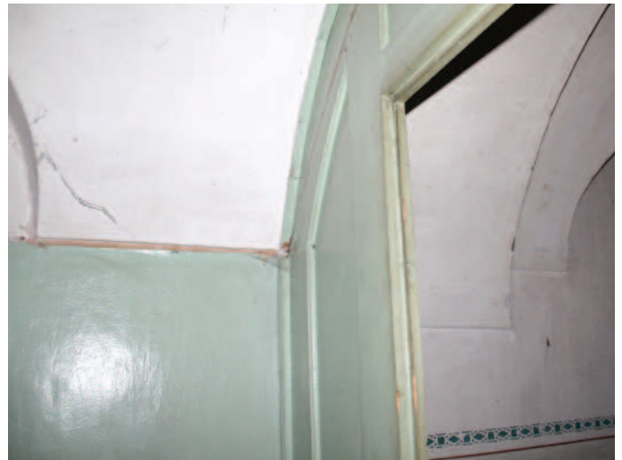
Erdgeschosskorridor. Detail mit hölzerner Trennwand und Schablonenmalereien, vermutlich um 1900. Foto DPG 2016
